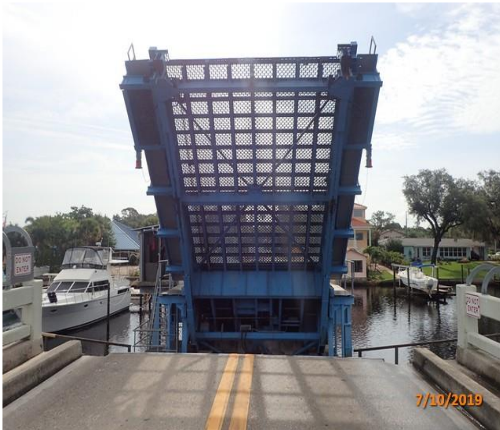
Photo A: Bascule Span Framing
