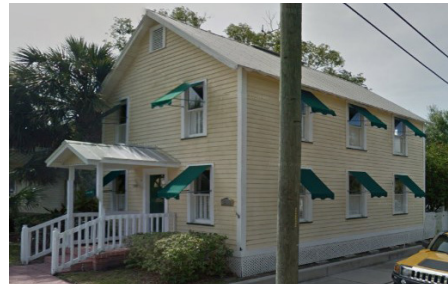
Van Valkenburg House, 1202 Nebraska Avenue
